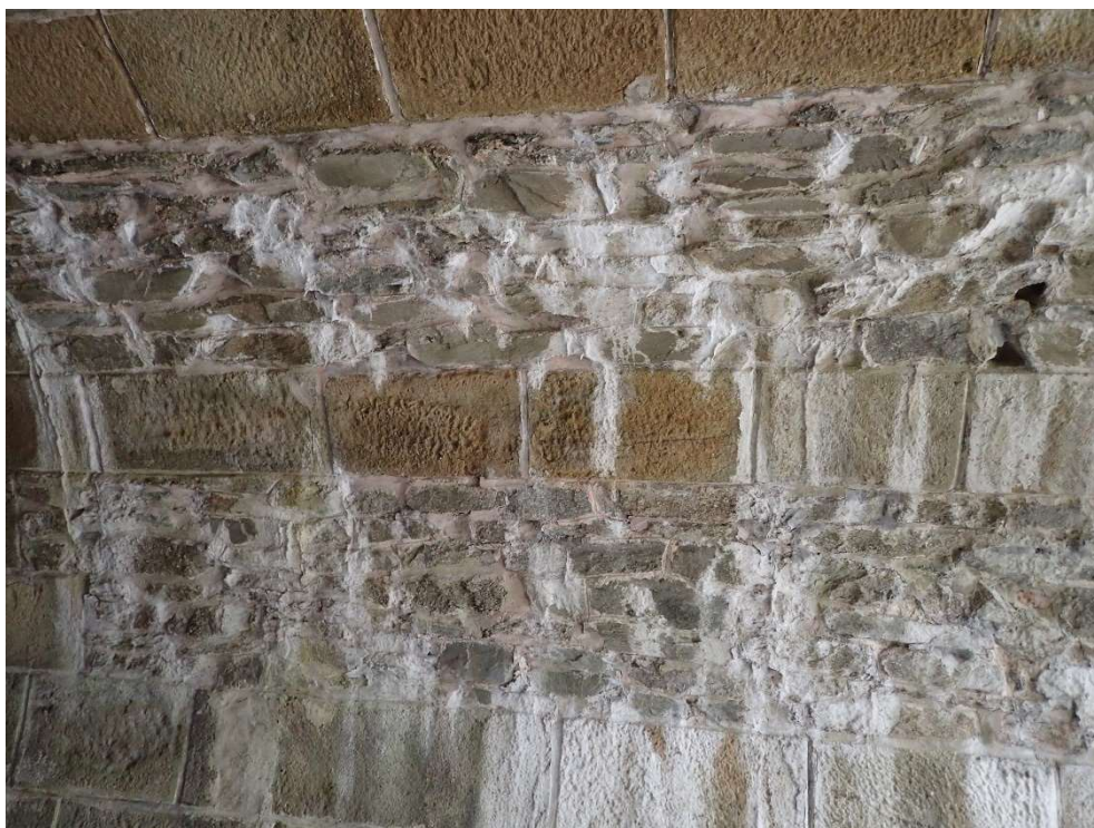
Foto 4: Degradování povrchu kamene včetně spárování
