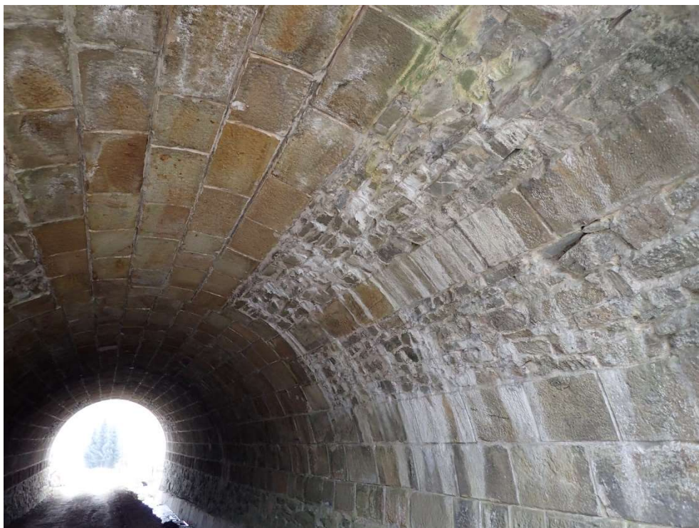
Foto 3: Patrné průsaky, výkvěty a vypadané spárování v klenbě
